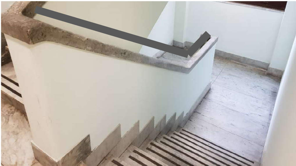
rialzo parapetto esistente mediante installazione di corrimano
