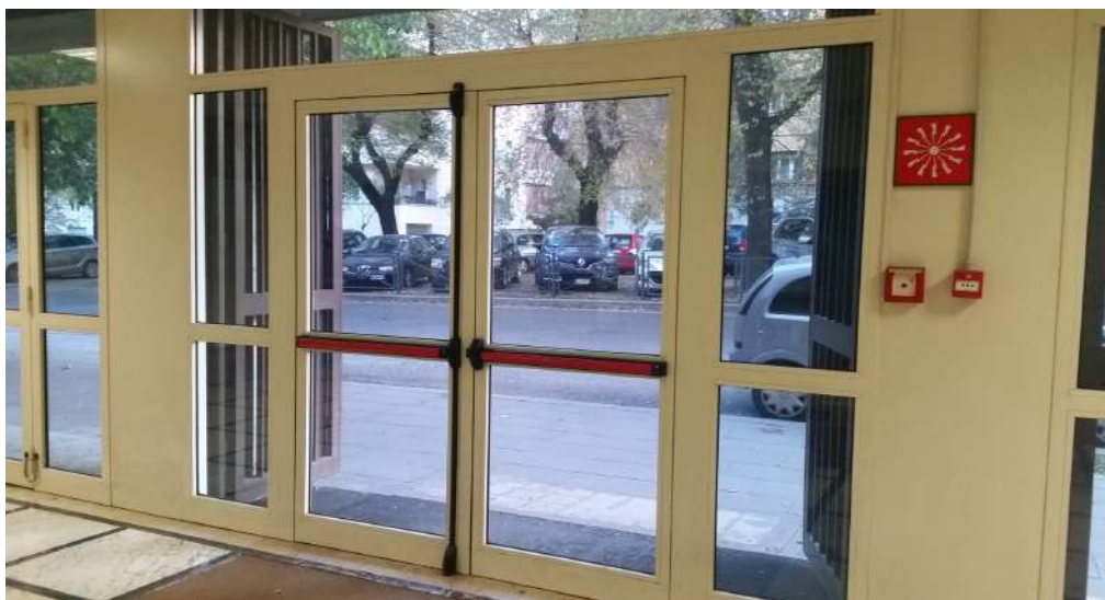
uscita di emergenza: vista dall'interno
