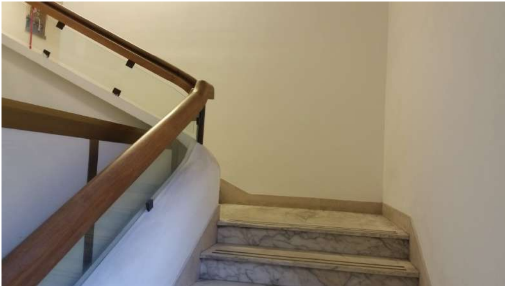
parapetto vano scala secondario h cm 100
