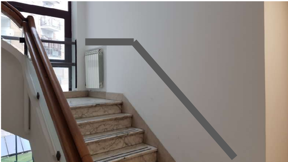
installazione secondo corrimano a muro
